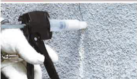
■ひび割れ注入作業(ハンドスーマー使用)
