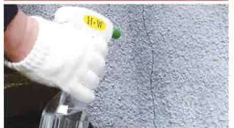
■ひび割れに対して高圧洗浄を行う内部洗浄
