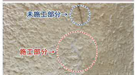
■ 施工終了後 HSS工法施工状況の比較
