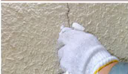
■ 注入充填後、ふきとり清掃仕上げ
